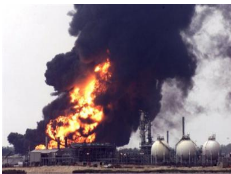
Рис. 2. Пожар в г. Вильгельмсбурге
