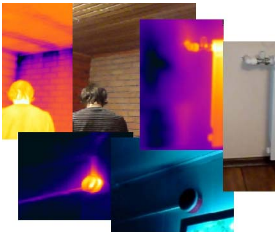
Рис. 5. Фрагменты изображений, полученных с тепловизора в помещении
